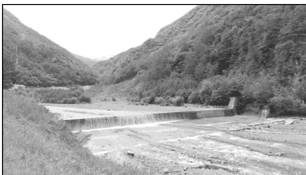
写真1 鳶が巣の手前の床固工
