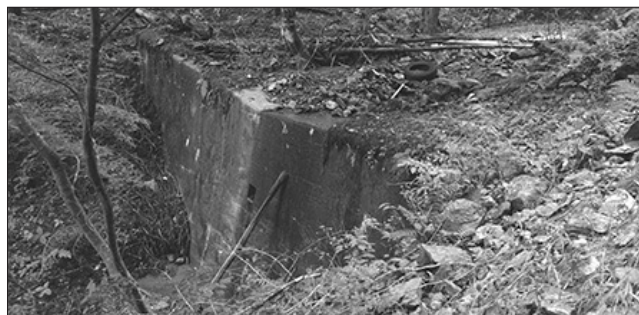
写真6 城の腰露頭下の砂防ダム
