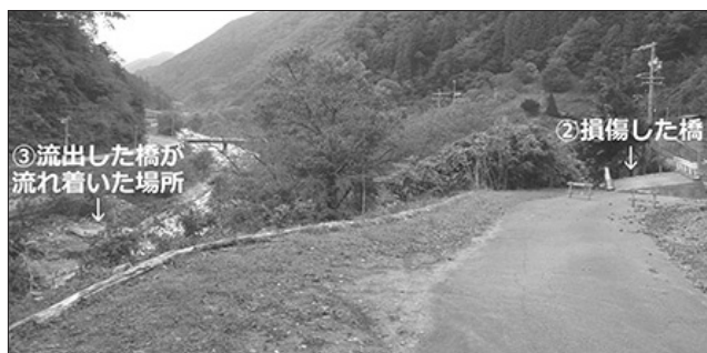
写真3 流出した橋は②の橋にぶつかって③の位置まで来た
