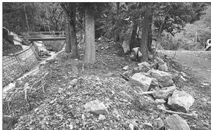
写真1 図1 地点①橋が流出した場所（現在は仮橋がかかっている）。川の流路に沿って、土石流の跡が残っている。
