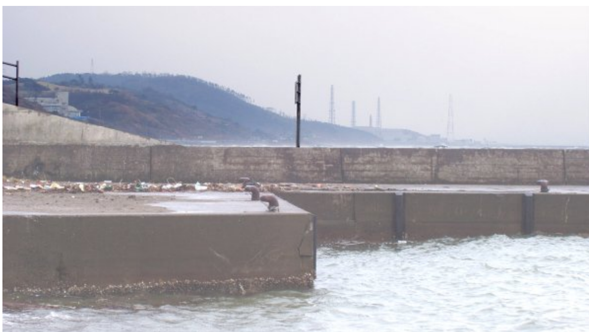
岸壁の海棲生物の付着上限線は隆起量を示す。遠景の鉄塔は柏崎刈羽原子力発電所。
