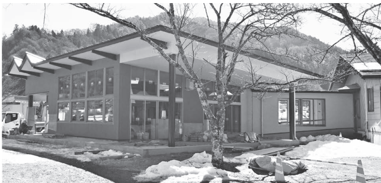
ろくべん館玄関棟施工状況 2月末
