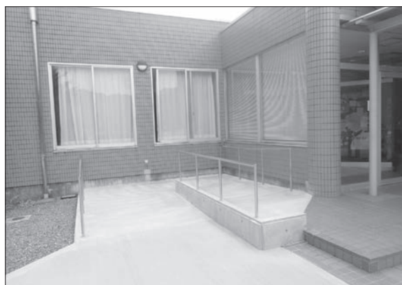
写真1 玄関にスロープが新設されました
